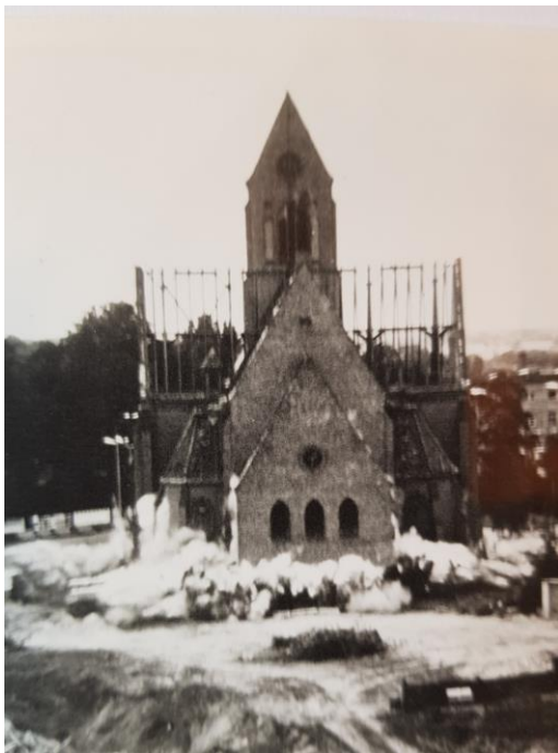
Sprengung der Christuskirche
